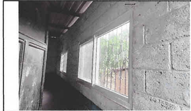
FOTO 4. VENTANAS DE PVC INSTALADAS
