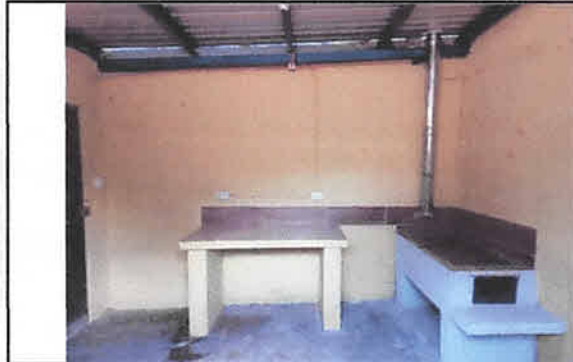
FOTO 3. ESTUFA TERMINADA Y SISTEMA ELÉCTRICO INSTALADO
