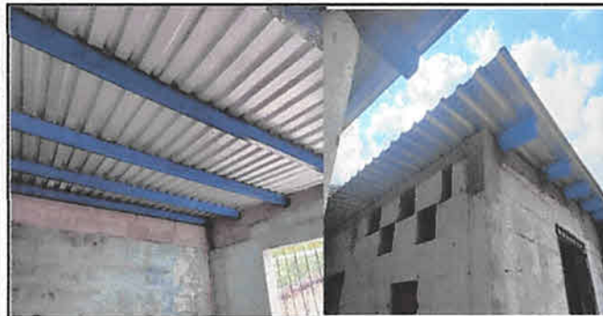
FOTO 5. INSTALACIÓN DE ESTRUCTURA Y LÁMINA TERMINADA
