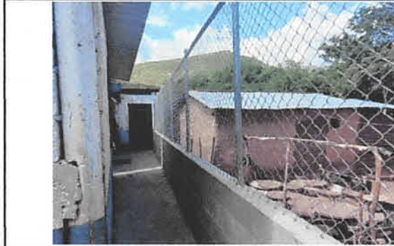
FOTO 1: CIRCULACIÓN CON MALLA TERMINADA EN LA PARTE POSTERIOR
